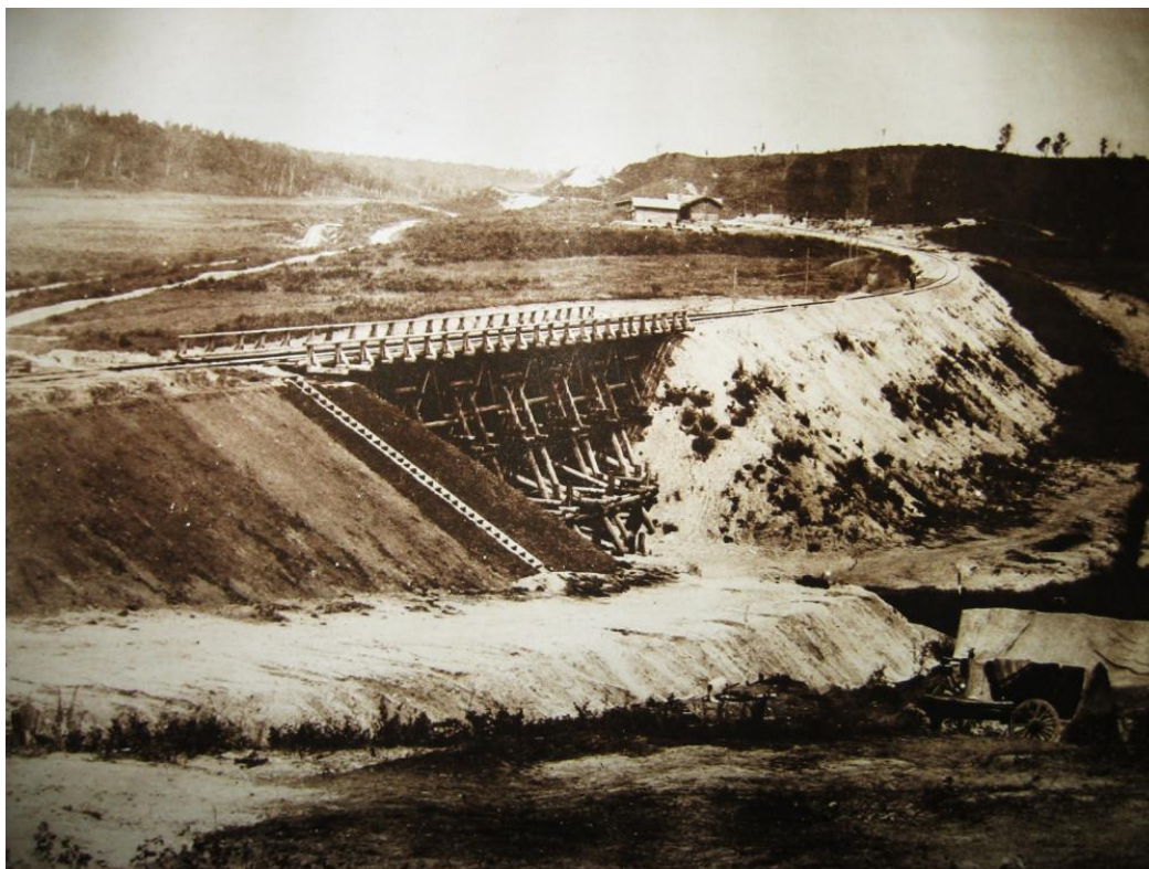
Рис. 6. Амурская железная дорога. Деревянный мост на 607-й версте. 1915 г. [7]
