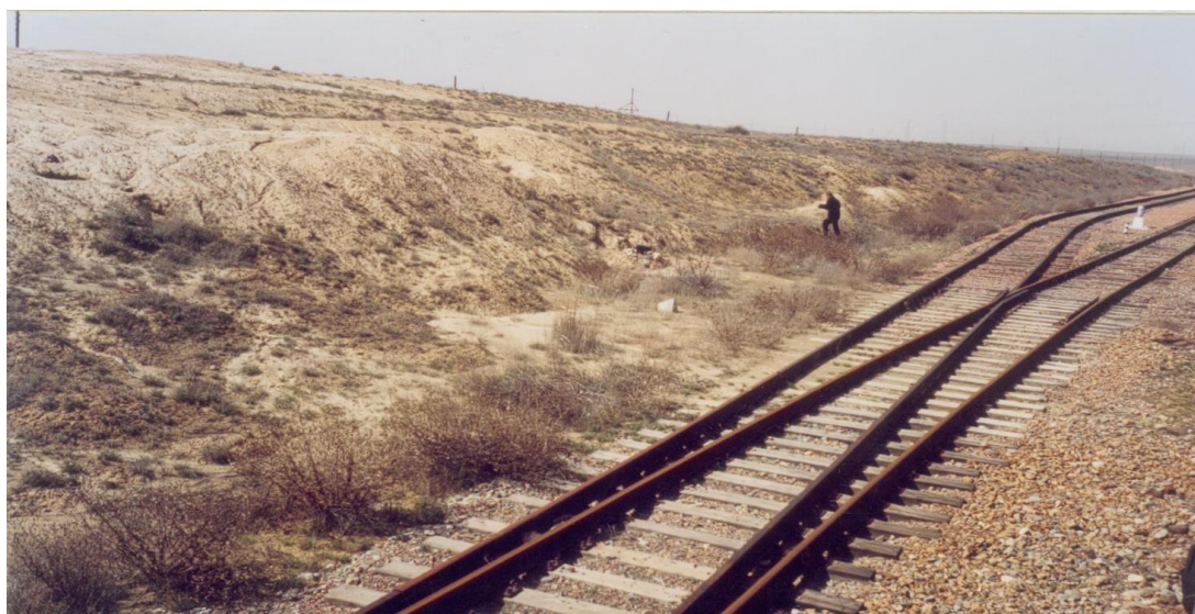
Рис. 1. Обследование откосов аварийной выемки
