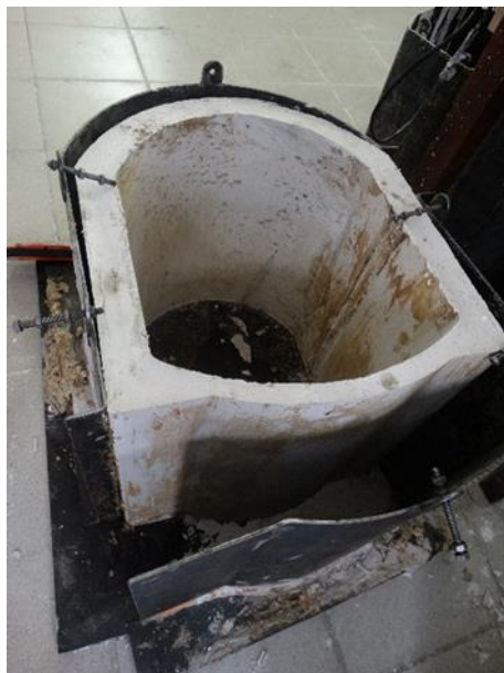
Рис. 7. Процесс создания монолитных сегментов стационарных тоннелей
