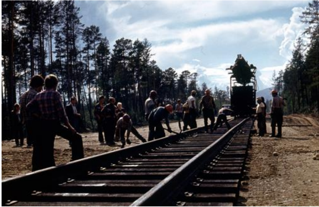
Рис. 3. Из опыта участия бойцов ССО «Интер-Бам» в укладке подъездных путей к МТбазе г. Северобайкальска
