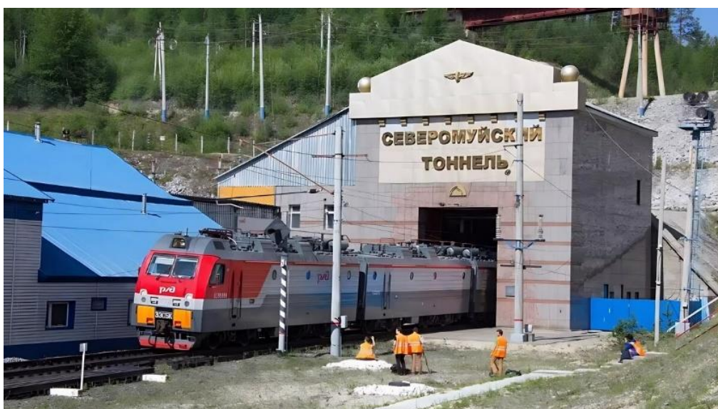
Рис. 2. Северо-Муйский тоннель на Байкало-Амурской магистрали https://company.rzd.ru/ru/9453/page/564703?id=550
